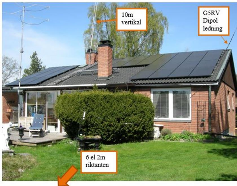
Figur 19: Antennerna är monterade omedelbart intill solcellsanläggningen.
