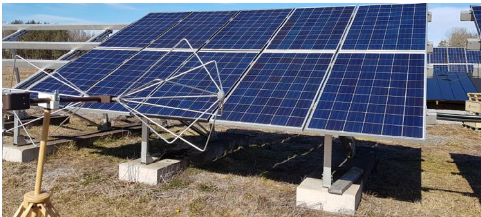
Figur 30: Solcellsanläggning med mycket hög störnivå.
