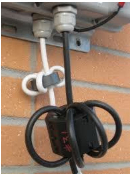
Figur 17: Ferriter på kablar.
