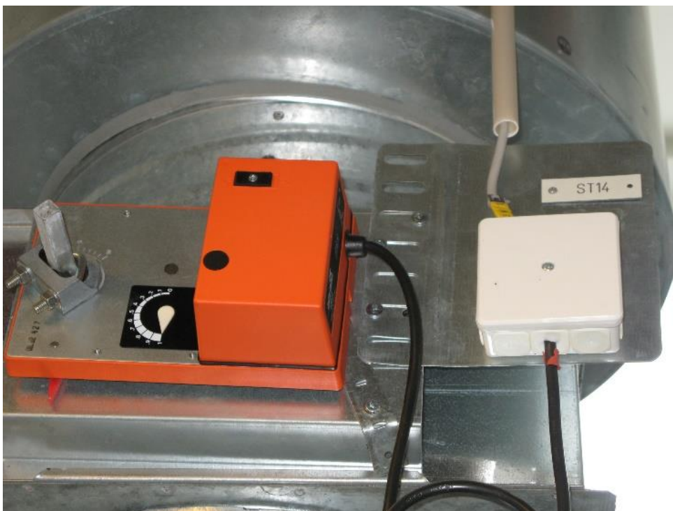
Figur 42: Ett ställdon i skolans ventilationssystem orsakade störningar.
