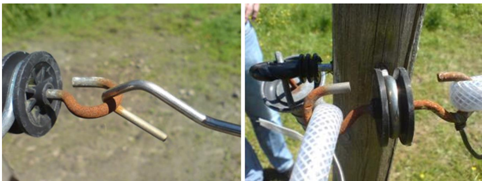
Figur 39: Dålig kontakt på grund av rostiga kontaktytor.
